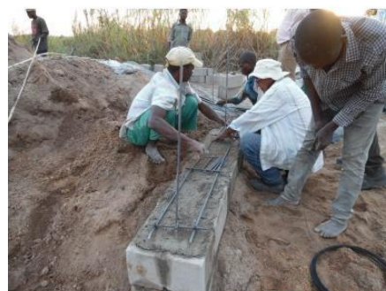
Construcción presa subterránea
