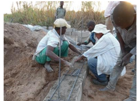
Construction d'un barrage souterrain
