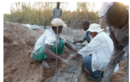
Construction d'un barrage souterrain
