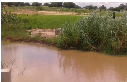
Barrage souterrain rempli d'eau (capacité jusqu'à 10'000m3 d'eau)
