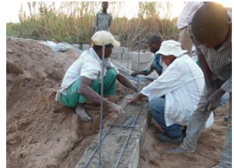
Строительство подземной дамбы
