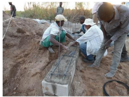
Construcción presa subterránea
