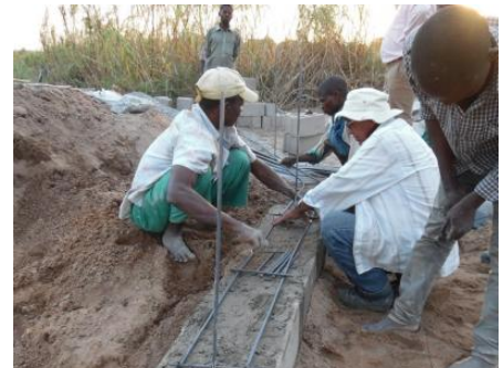
Construction d'un barrage souterrain
