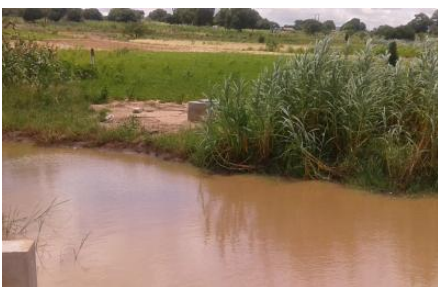
Barrage souterrain rempli d'eau (capacité jusqu'à 10'000m3 d'eau)
