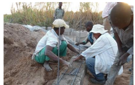
Construction d'un barrage souterrain
