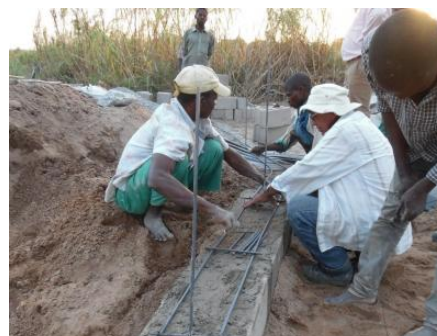
Строительство подземной дамбы
