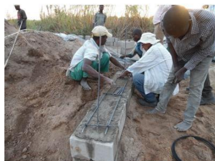
Construcción presa subterránea
