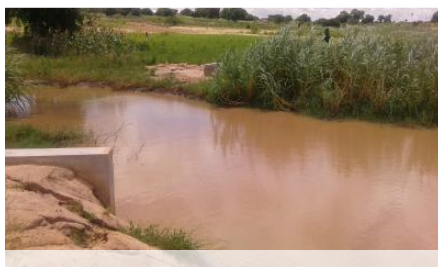
Presa subterránea llenada con agua
